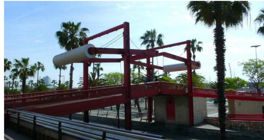
**Imagen 3-21. Puentes basculantes, Muelle de la Fusta.**
