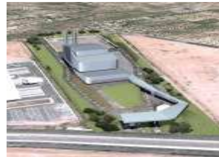
Planta de Valorización Energética de residuos municipales en Valencia TÉCNICAS Y TRATAMIENTOS ENERGÉTICOS DE RESIDUOS, S.A. • Waste-to-energy
