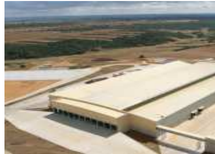
Centro de Tratamiento de Residuos (CTR) de San Román de La Vega en León TECMED/FCC • TMB (reciclaje, compostaje, biometanización) • Vertedero de rechazos
