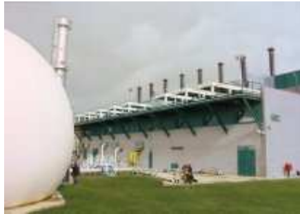
Sellado, clausura, desgasificación y aprovechamiento energético del biogás del vertedero de Madrid CESPA/SUFISA/VERTRESA • Confinamiento • Landfill gas-to-energy
