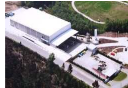
Planta de residuos voluminosos en Galicia XUNTA DE GALICIA • Desmontaje, descontaminación y reciclaje de Residuos de Aparatos Eléctricos y Electrónicos
