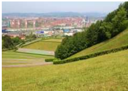
Celda de Seguridad para residuos peligrosos y suelos contaminados en Barakaldo (País Vasco) GOBIERNO VASCO – IHOBE • Confinamiento
