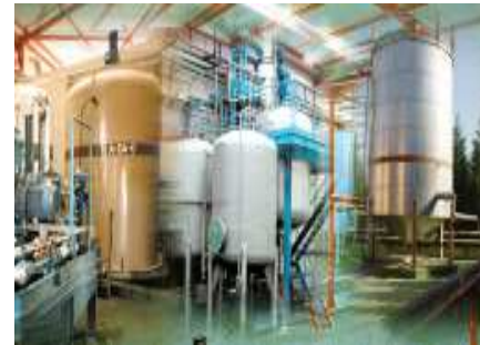
Centro Avanzado de Reciclaje de Residuos Peligrosos Especiales en el País Vasco GOBIERNO VASCO-IHOBE • Regeneración/recuperación de aceites usados, taladrinas y disolventes
