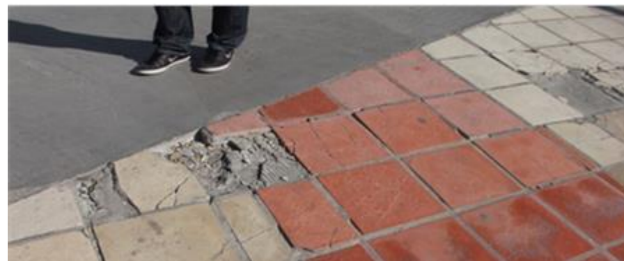
Imagen 13-1 Condiciones de la infraestructura urbana. Fuente: Elaboración propia.
