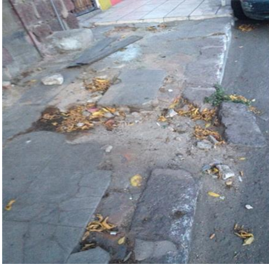
Imagen 13-4 Condiciones de la infraestructura urbana. Fuente: Elaboración propia.
