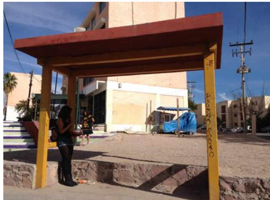
Imagen 13-8 Condiciones de la infraestructura urbana paradas de autobús. Fuente: Elaboración propia.
