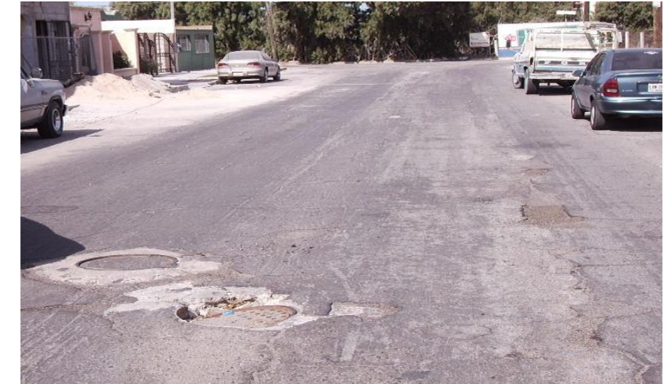
Imagen 4-21 Ejemplo de vialidad asfaltada deteriorada por falta de conservación y mantenimiento. Fuente: PSCVT
