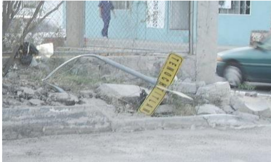
Imagen 4-20 Ejemplo de señalética vertical dañada. Fuente: PSCVT
