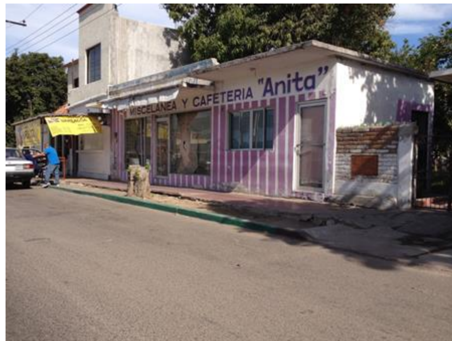
Imagen 13-6 Condiciones de la infraestructura urbana. Fuente: Elaboración propia.
